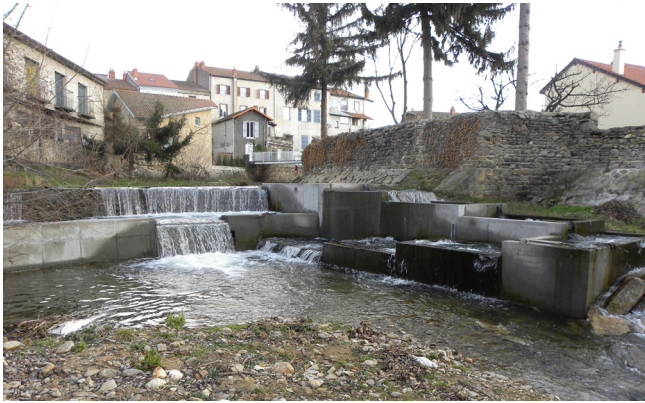
Travaux de restauration sur l'Allagnonnette (passe à poissons) à Massiac. © SMPNRVA, C. Birard, 2013.
